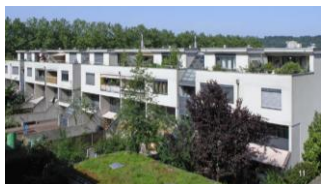
Längacker, Wettingen Wohnüberbauung mit 160 Wohnungen Baujahr 1982
