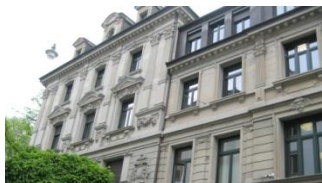
Bahnhofstrasse 13/17, Zürich Geschäftshaus Baujahr 1896, Sanierung 1979
